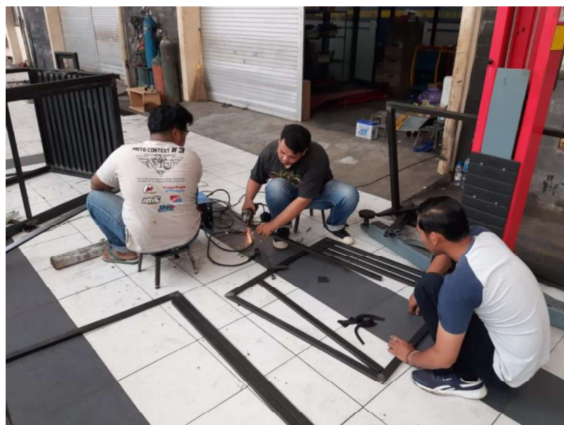
Gambar 3 9. Proses pemotongan besi sebagai rangka bilik.
