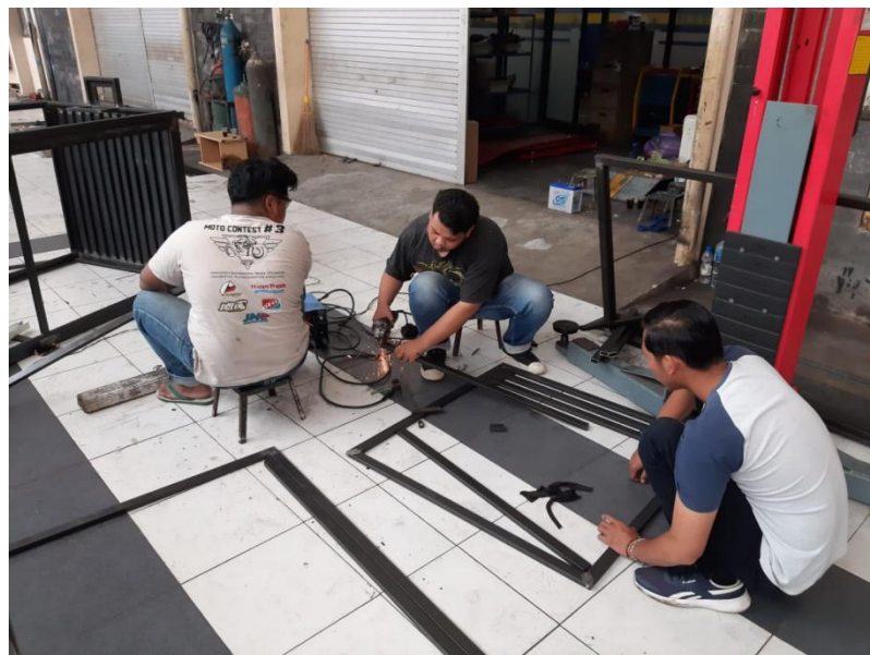
Gambar 3 9. Proses pemotongan besi sebagai rangka bilik
