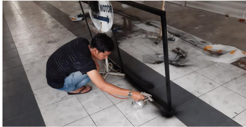
Gambar 3.10. Proses pengecatan rangka bilik.
