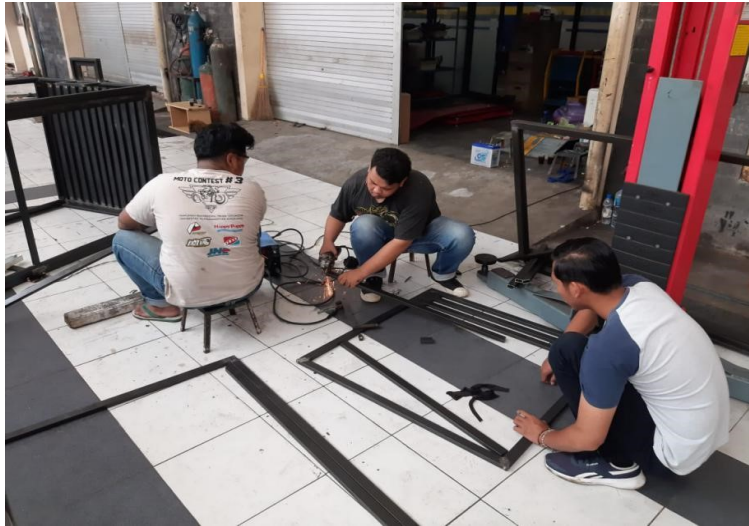
Gambar 3 9. Proses pemotongan besi sebagai rangka bilik
