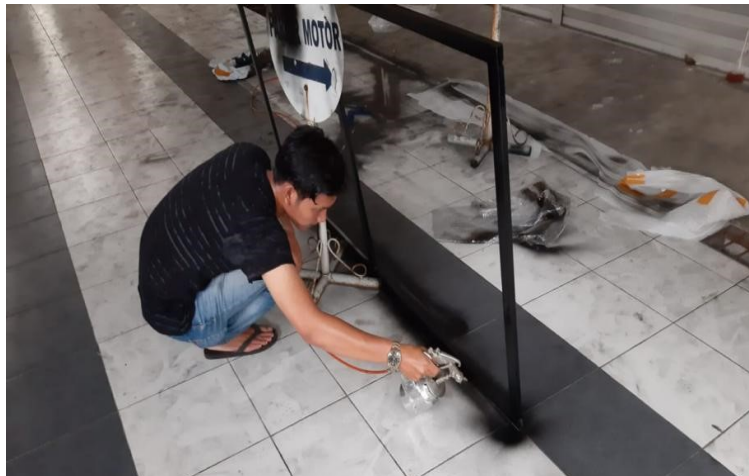
Gambar 3.10. Proses pengecatan rangka bilik
