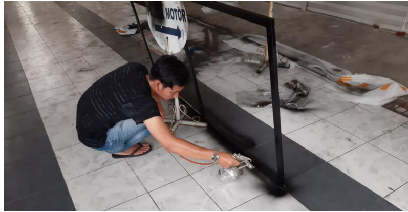
Gambar 3.10. Proses pengecatan rangka bilik
